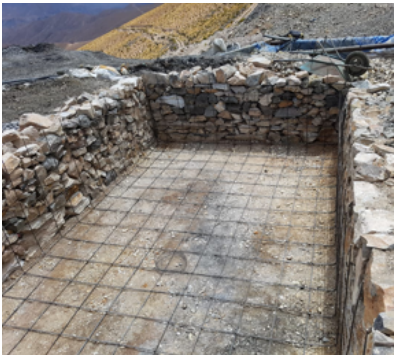
Fotografía 2: Piscinas de recirculación de agua en construcción
